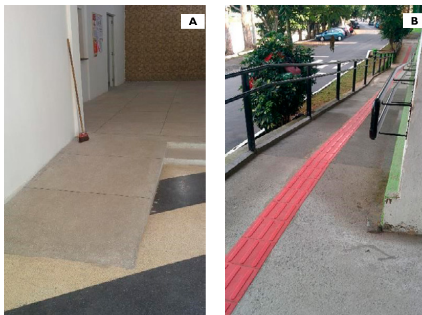
Figura 82 Acessibilidade dos deficientes no Campus Resende. A. Rampas. B. Piso tátil.
