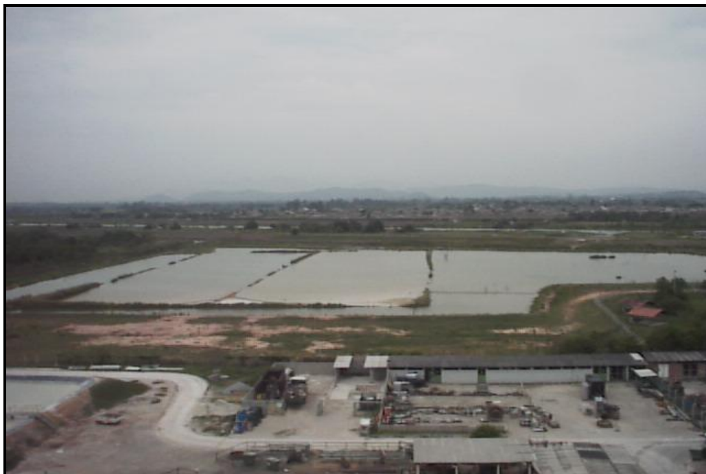
Imagem 2 :início da descontaminação com a água proveniente da área de utilidades.
